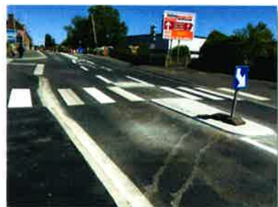
Amiens – rue Robert Le Coq Vérification du franchissement du passage à niveau après travaux - Septembre 2018
