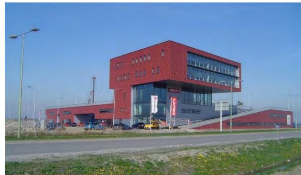
Utilisation des toitures de bâtiments mixtes ZA Oudeland, Berkel-en-Rodenrijs (Pays-Bas)
