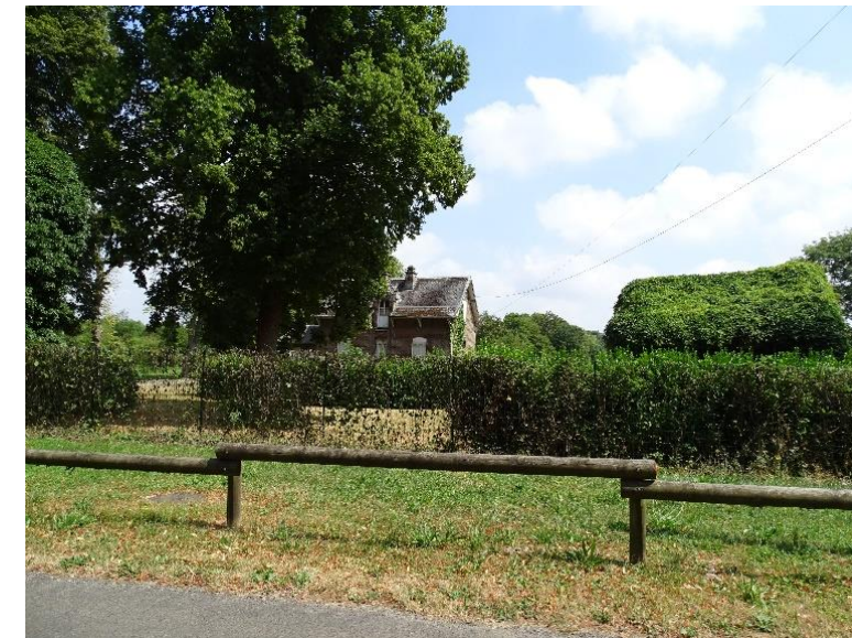
Figure 19 : Site clôturé du captage de Pont-de-Metz
