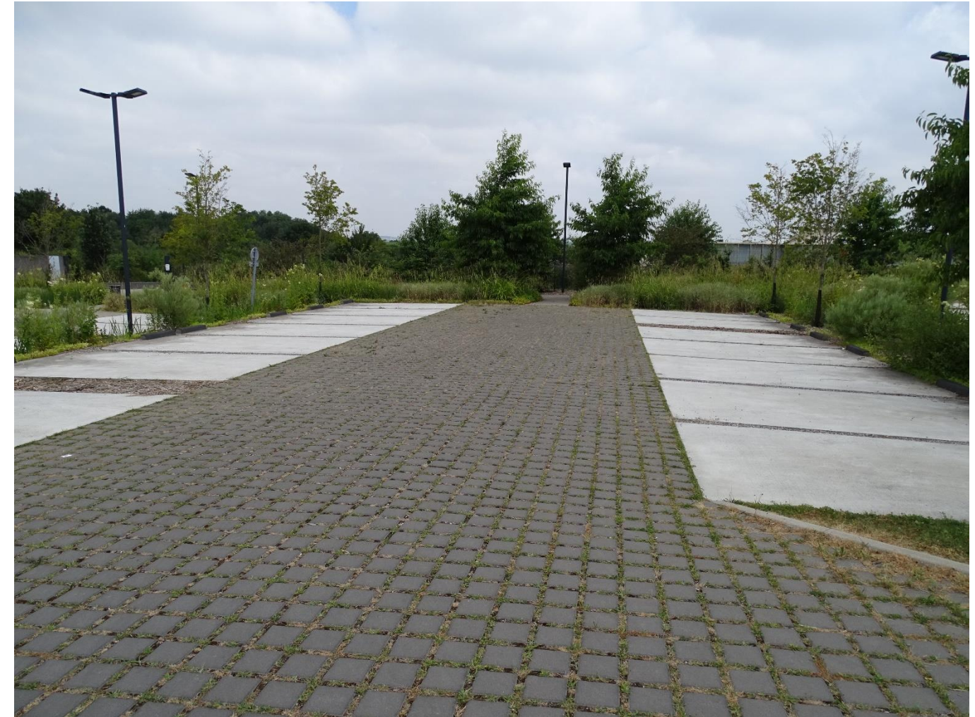
Figure 84 : Parking du crematorium (Source : 2AD)
