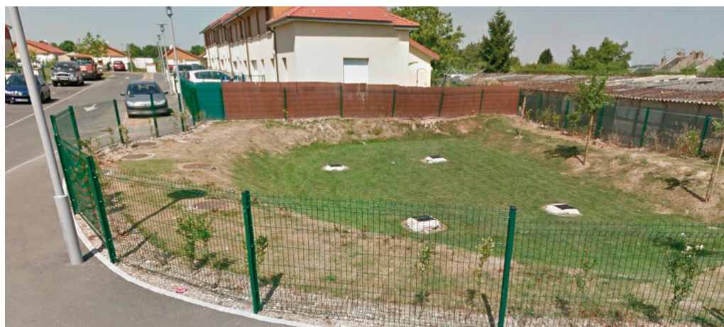
Amiens rue des vanniers - A la fin des travaux
