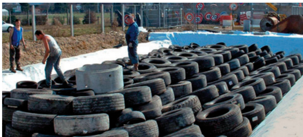
Bassin de pneumatiques empilés
