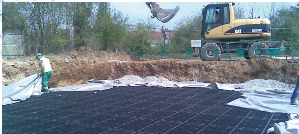
Amiens rue des vanniers - Pendant les travaux
