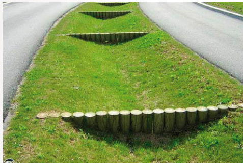
Noue d'infiltration avec cloisons
