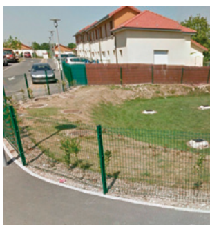
Amiens rue des vanniers A la fin des travaux © DR
