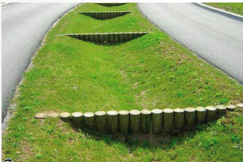
Noue d'infiltration avec cloisons
