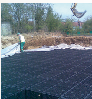
Amiens rue des vanniers Pendant les travaux © DR
