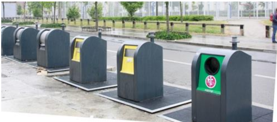
Installation de conteneurs enterrés à chaque nouvel aménagement
