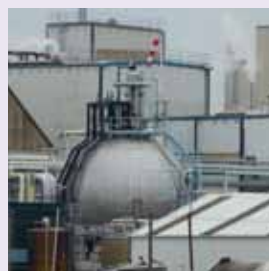
Sphère de stockage d'ammoniac de l'usine Ajinomoto d'Amiens
